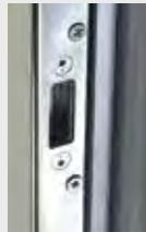
durchgehende Schließleiste im Blendrahmenstahl verschraubt
