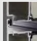
**Isolierzone aus PA-Isolierstegen für optimierte thermische Trennung.**
